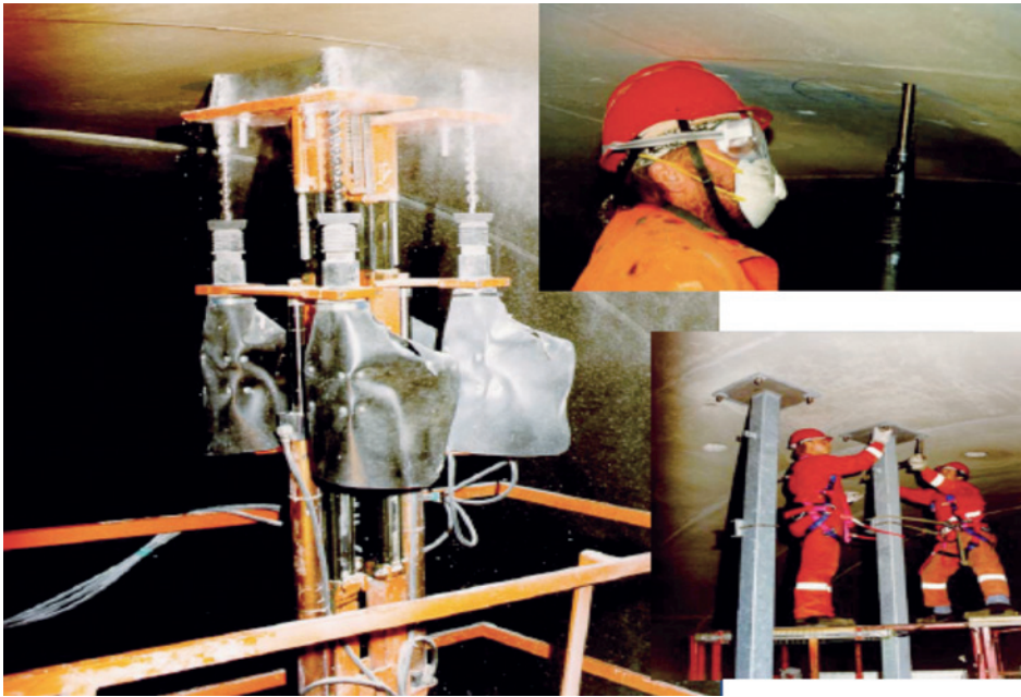
Abb. 27: Montagetechnologie - Bohren mit 4er-Lafette - Bolzen versetzen - Stützpunktmontage
