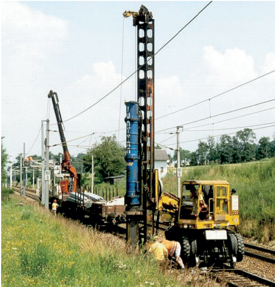
Abb. 26: Montagetechnologien – Rahmen der Stahlfundamente
