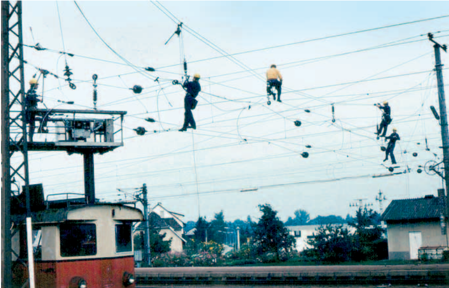
Bild 1: Herkömmliche Oberleitungsmontage.
