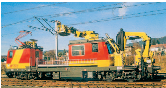
Bild 11: Motorturmwagen im Einsatz.
