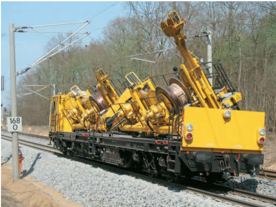
Bild 4: Oberleitungsumbau- und -neubaumaschine im Einsatz.
