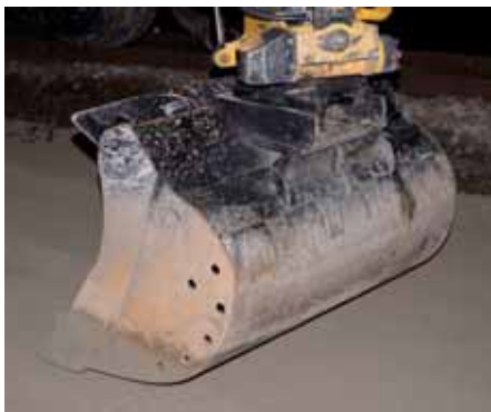
Abb. 3: Einbringung des neuen PSS-Materials
