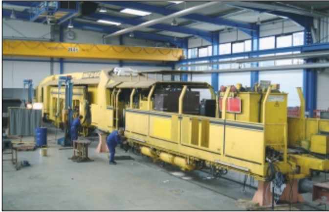
Abb. 3: Reparaturstandort Freilassing (Fa. Robel)
