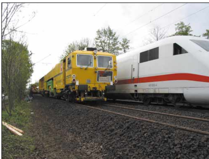
Abb. 4: Kombinierte 3-Schwellenstopfung und Gleisstabilisation im Einsatz auf einer Großbaustelle
