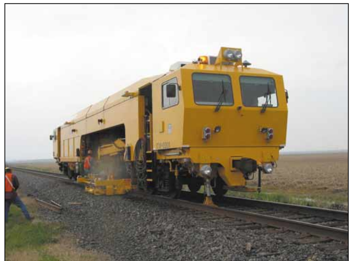
Abb. 6: Mobile Abbrennstumpfschweißmaschine mit integrierter Schienenspanneinrichtung
