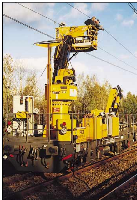
Abb. 3: FKW 2 beim Kontrollieren der Fahrleitungs-Isthöhe
