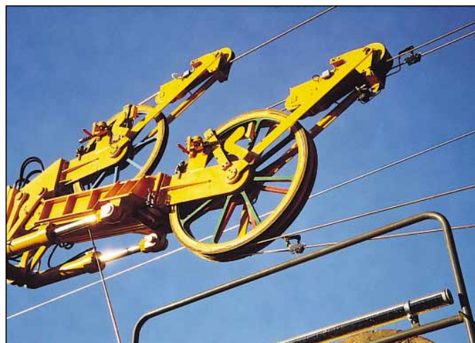
Abb. 2: Umlenkrollen für die Fahrdrabtverlegung
