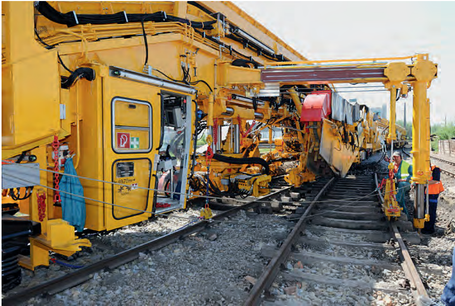
Bild 12: Abstützung der Aushubeinrichtung am vorderen Ende
