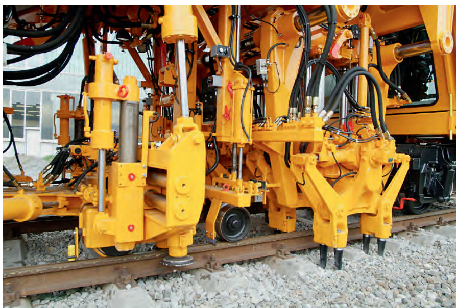
Bild 2: Einfaches Split-Head-Stopfaggregat mit kombiniertem Hebe- und Richtaggregat
