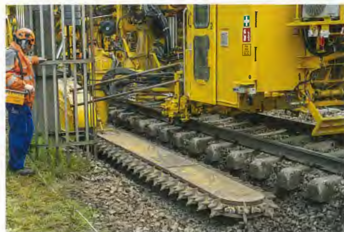
Das Aushubswert wird an der abgeräumten Bettungsflanke parallel zur Schiene abgesenkt und unter die Schwellen geschwenkt.
