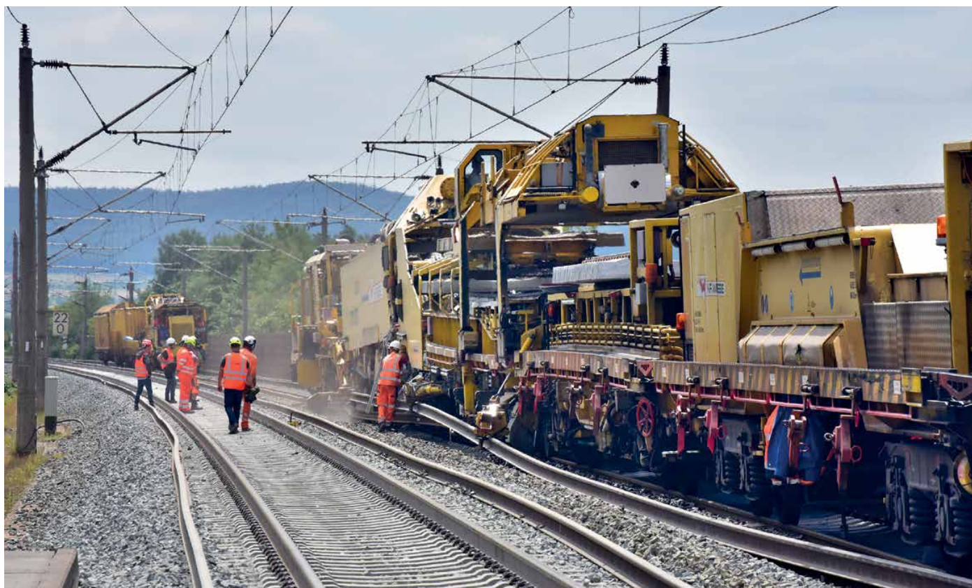
Der Schnellumbauzug tauscht Schwellen und Schienen zugleich – mit erstaunlichem Tempo. Das Richtungsgleis links ist schon erneuert.
