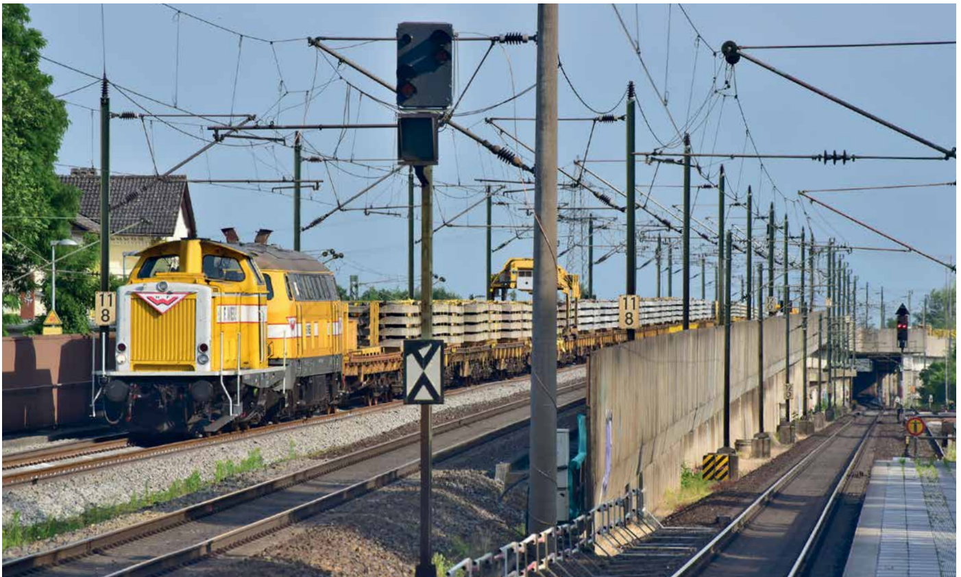
An der nördlichen Ausfädelung der Neubaustrecke Hannover – Göttingen in Rethen wird die Zu- und Abfuhr von Schwellen gesichert.
