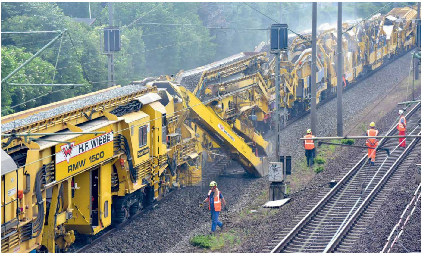
Erster großer Schritt bei der Sanierung ist die Schotteraufbereitung samt Neuschotterzufuhr. Räumketten bauen den alten Schotter aus.
