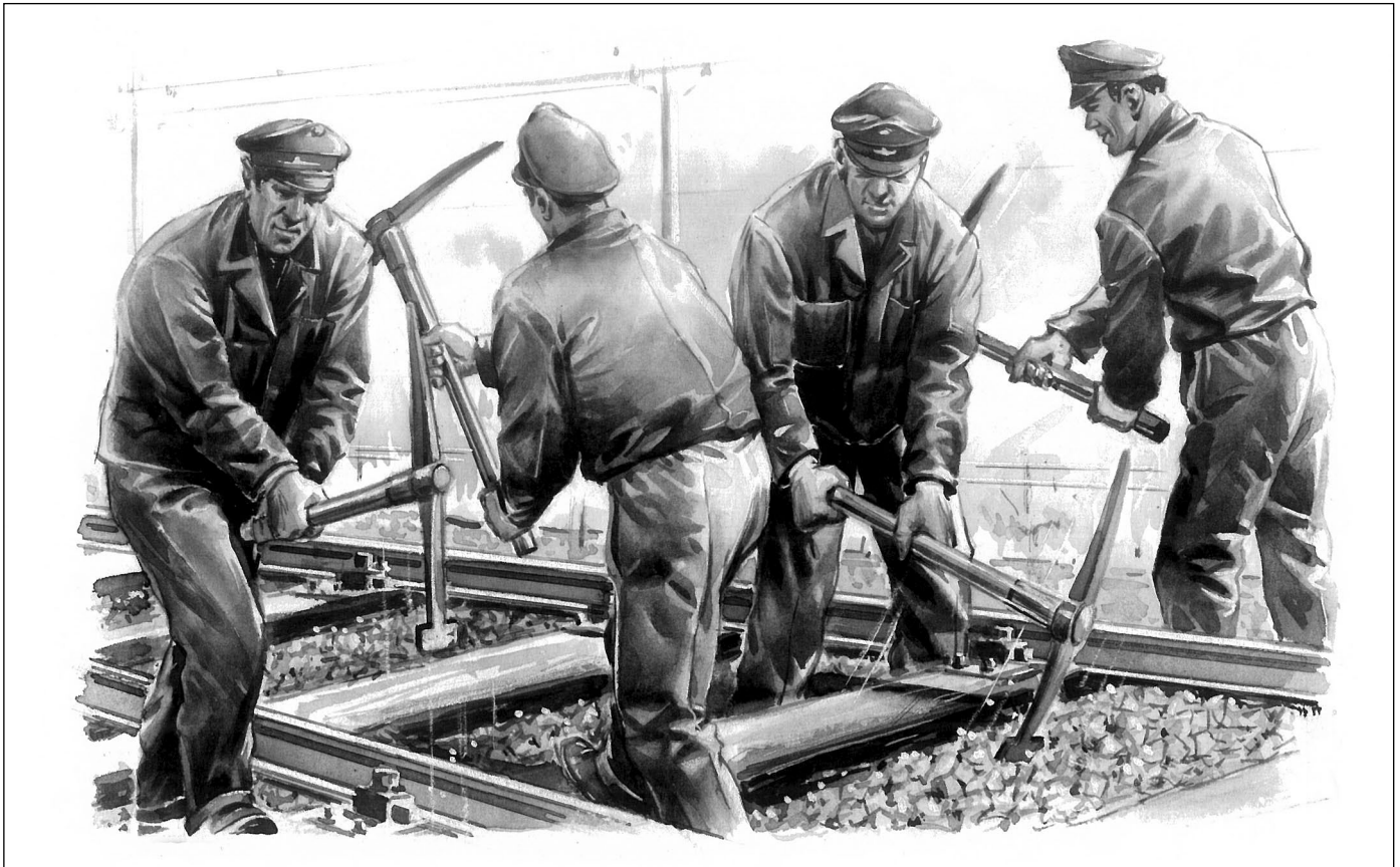
Abb. 1: Manuelle Unterstopfung
