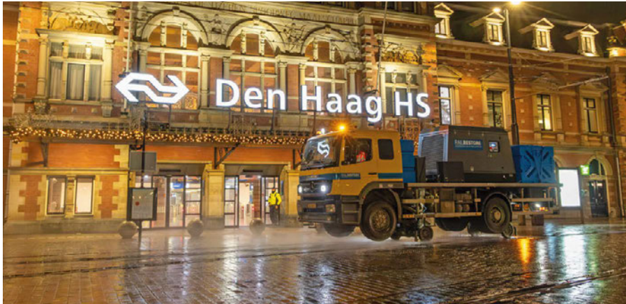
3: Zwei-Wege-Fahrzeug für die urbane Anwendung beim Einsatz in Den Haag
