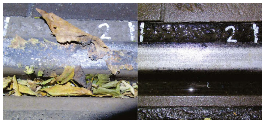
4: Schienenoberfläche und Rille vor (links, kontaminiert) und nach (rechts, sauber) dem Reinigen
