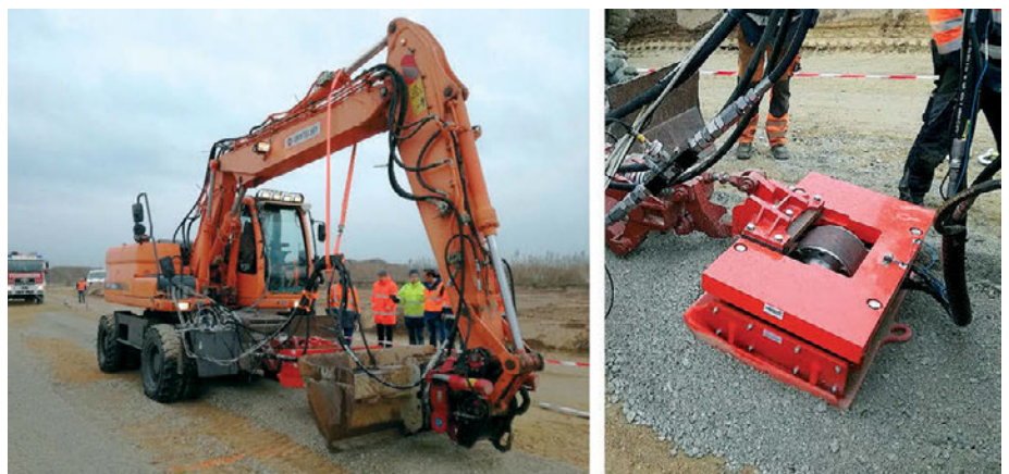
Abb. 2: Plattenverdichter während der Feldversuche in einer Kiesgrube bei Wien
