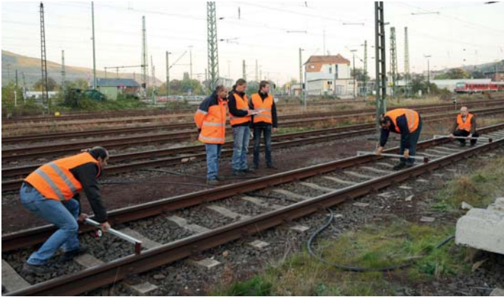
Abb. 3: Die praktischen Trainings finden auf realen Bahnanlagen statt. Fig. 3: Practical training on real railway installations
