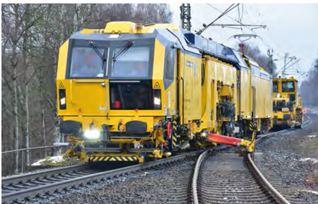
Vollelektrisch angetriebener Unimat 09-4x4/4S E 3 am Gleis in Linz
