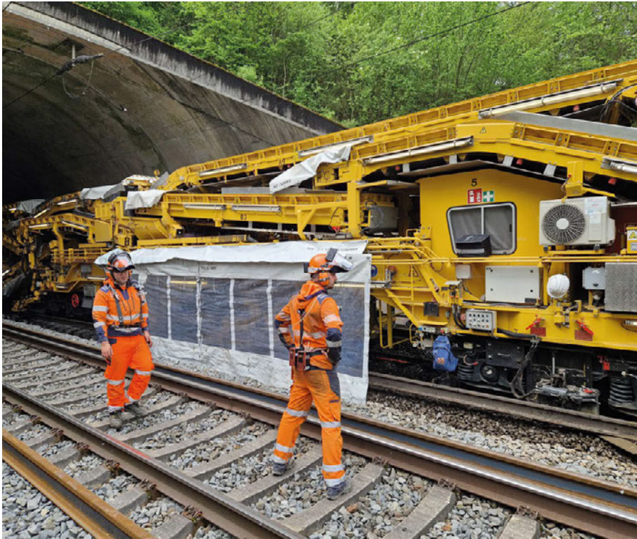
4: Staubreduziertes Arbeiten bei Kassel–Fulda mit der RUS 1000 S
