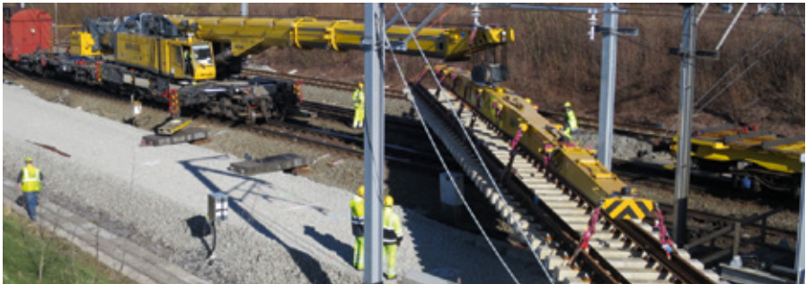
Abb. 13: Weichenerneuerung: Infrabels Kirow-Kran im Einsatz
