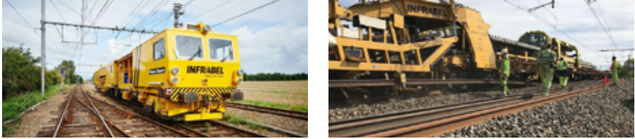
Abb. 6 (Links und rechts): Mechanisierung der Instandhaltung und Gleiserneuerung
