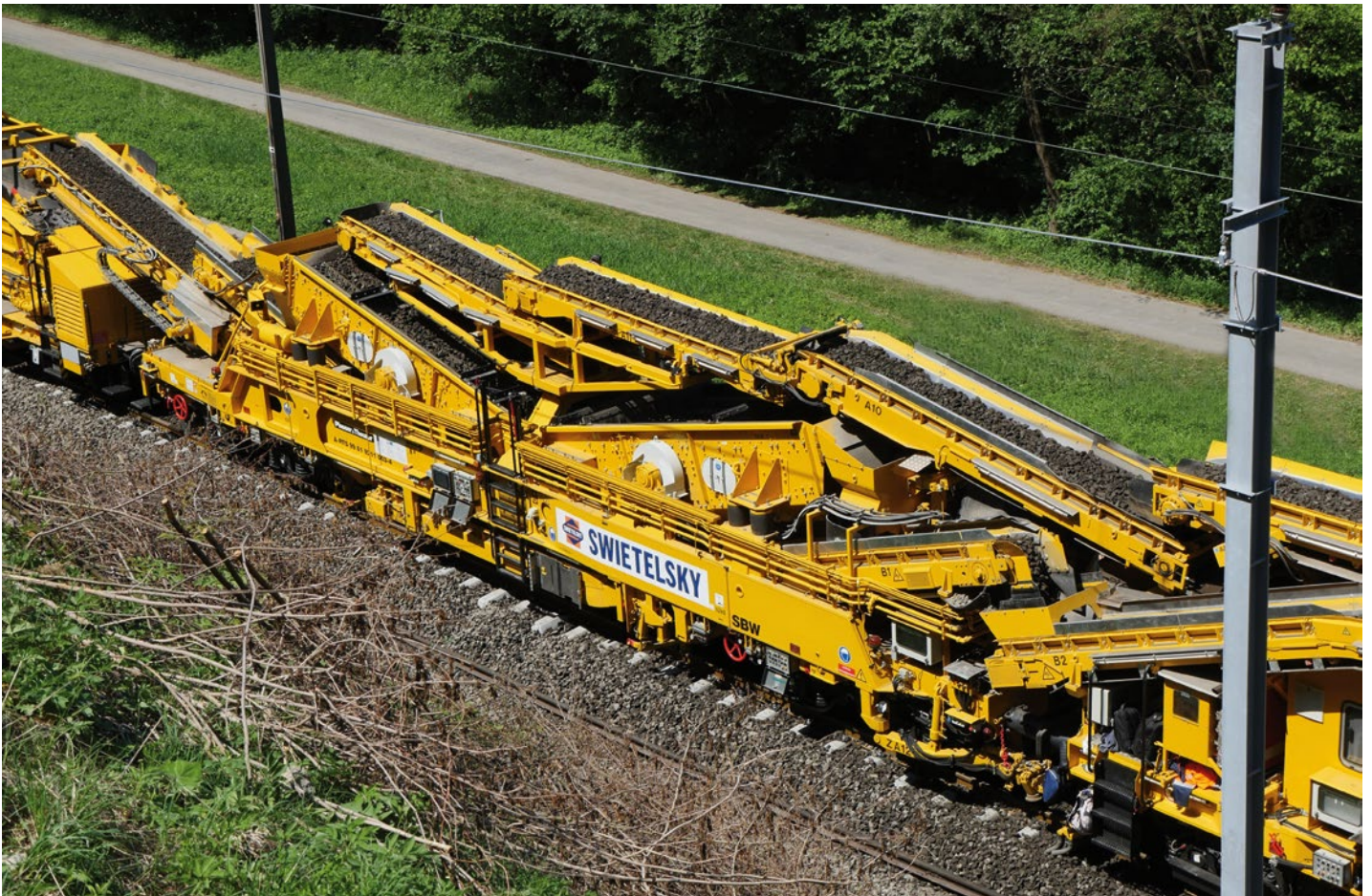
Der gesamte aufgenommene Schotter wird zur Hochleistungs-Doppelsiebanlage gefördert und gereinigt.
