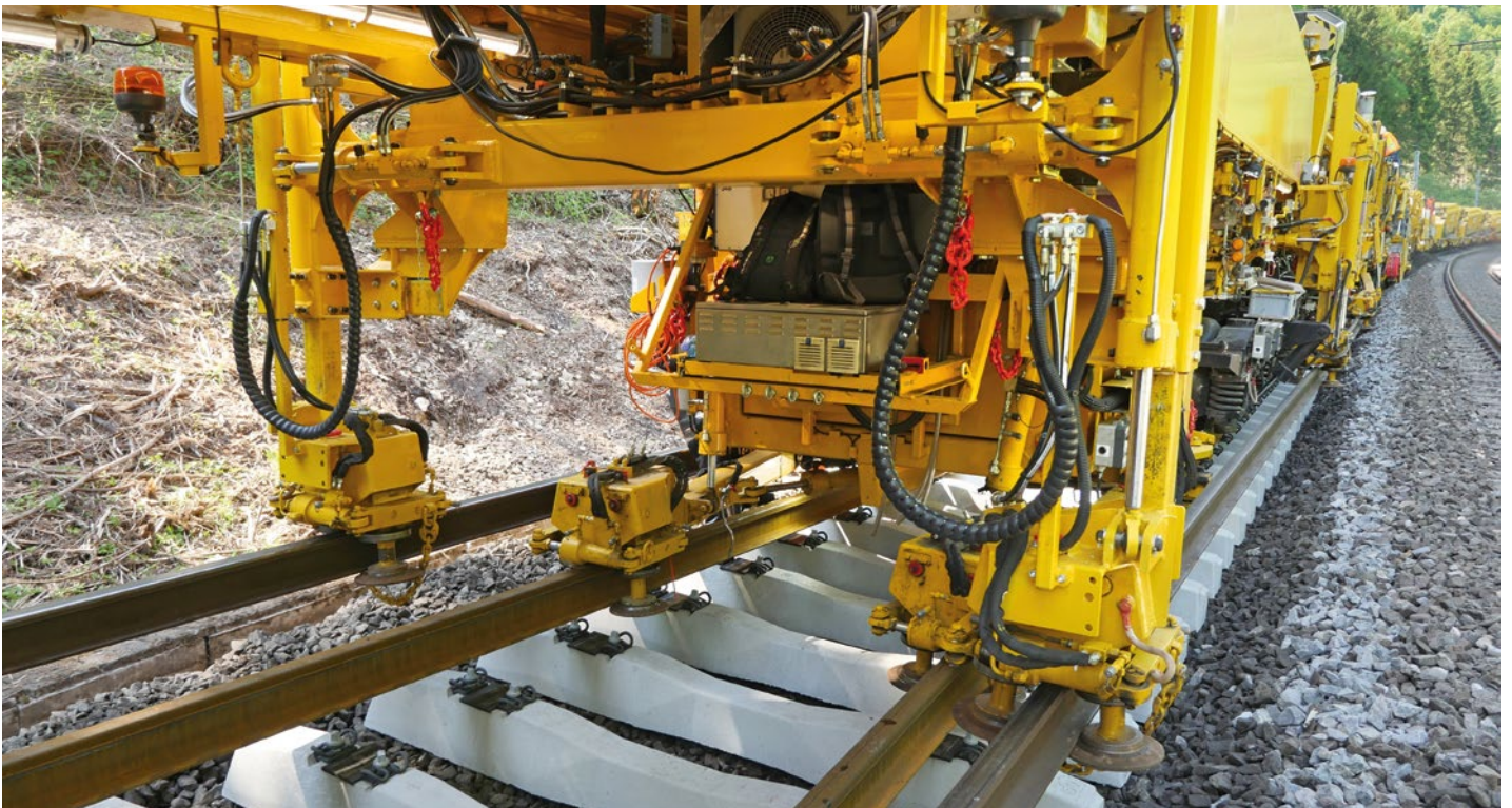
Das Arbeitsprinzip der RUS 1000 S ermöglicht die gleichzeitige Erneuerung der Schienen, der Schwellen und des Schotters in einer Baulücke von nur sechs Metern.
