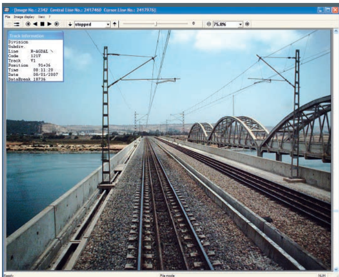
BILD 5: Anschauliche Darstellung der Infrastrukturanlagen mittels Gleisumgebungs-video
