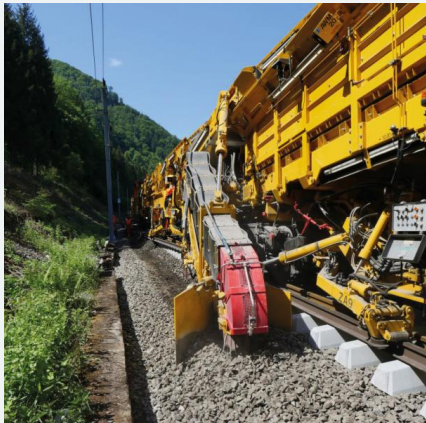
Bild 5: Zwei Flankenaufmehreinheiten für den restlichen noch zu reinigenden Schotter und Übergabe an Förderbänder für den Weitertransport zum Siebwagen
