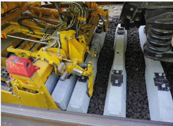
Bild 8: Präzise Verlegung von bis zu zehn Neuschwellen pro Minute
