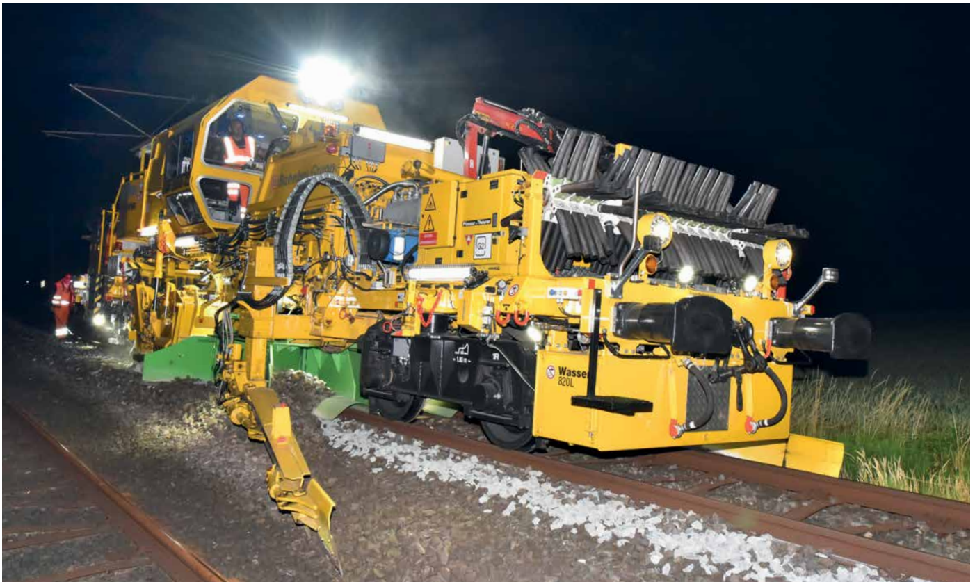
Oft nachts im Einsatz: Universalschotterverteiler- und Planiermaschine (USP) der DB Bahnbaugruppe mit ausgefahrenen Flankenpflügen.
