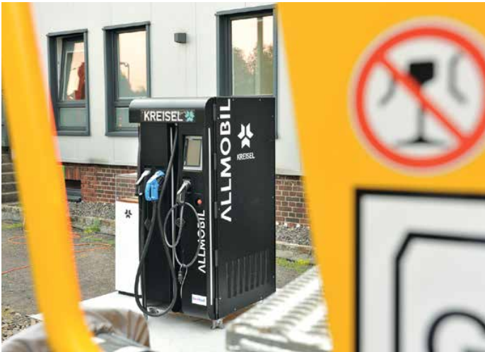
Oben links: Ein klappbarer Frontübergang ermöglicht den sicheren Wechsel auf ein angehängtes Fahrzeug. Oben rechts: Für die Präsentation von Oberleitungsarbeiten mit Trommelwagen und HTW100 E 3 war auf der iaf 2017 in Münster erstmals ein Fahrdraht montiert worden. Unten links: Die Tanksäule puffert Energie zwischen und gibt sie bei Bedarf schnell an ein angeschlossenes Elektrofahrzeug ab. Unten rechts: Eine mächtige, aber auch elegante Erscheinung ist der HTW100 E 3 mit seinen zwei Kabinen im neuen Design.
