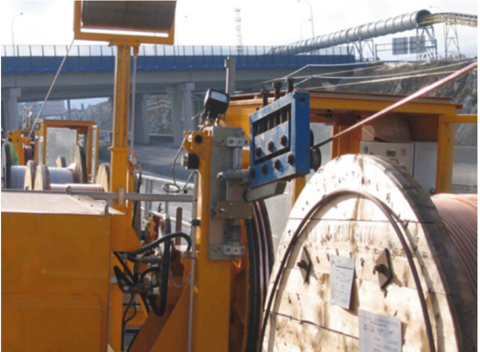
Abb. 5: Rollenrichttechnik im Einsatz im Projekt Madrid – Segovia (Spanien)
