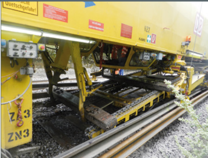
BILD 3: Altschwellaufnahme mit dem SUM 315 (Quelle: Autor)
