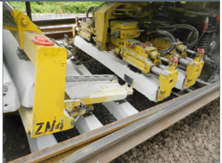
BILD 4: Neuschwellenablage im Zweischwellentakt mit dem SUM 315 (Quelle: Autor)
