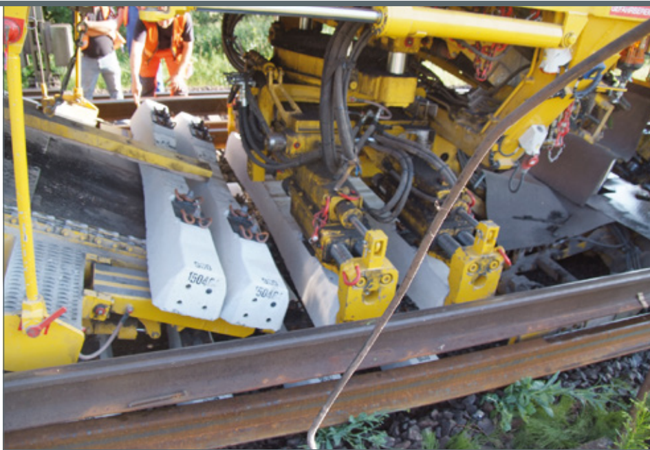
BILD 8: Schwellenverlegung im Zweiertakt mit dem SUZW 500 (Quelle: H. F. Wiebe)
