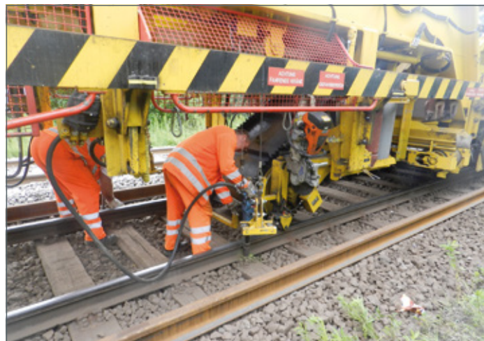
BILD 4: Neuschwellenablage im Zweischwellentakt mit dem SUM 315 (Quelle: Autor)
