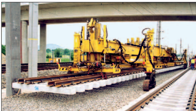
Abb. 4: Weicheneinbaugerät PK1
