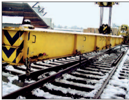
Abb. 3: Schienenzange am Rahmentragwerk (links) – Anschlagmittel an Traverse (rechts)
