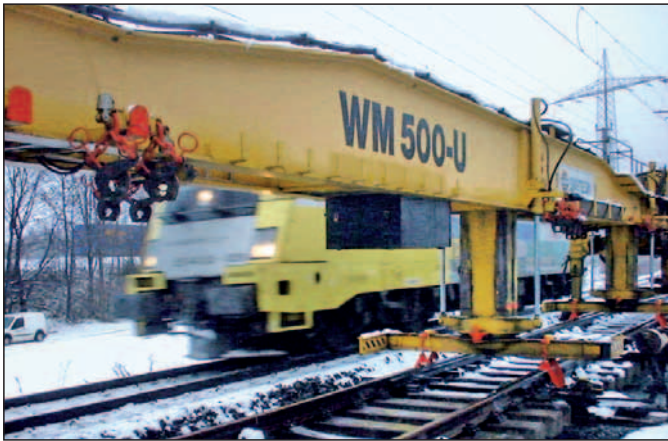
Abb. 2: Einbau einer Weiche mit WM 500 (links) und Eisenbahndrehkran (rechts)
