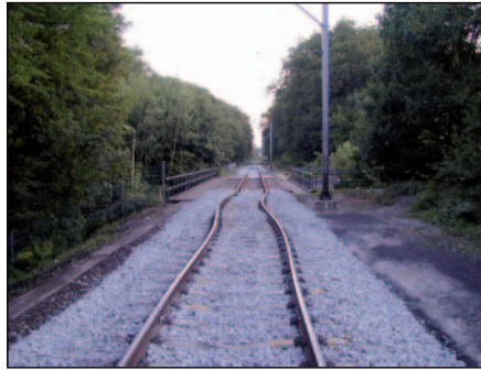
Abb. 3: Gleisverwerfung
