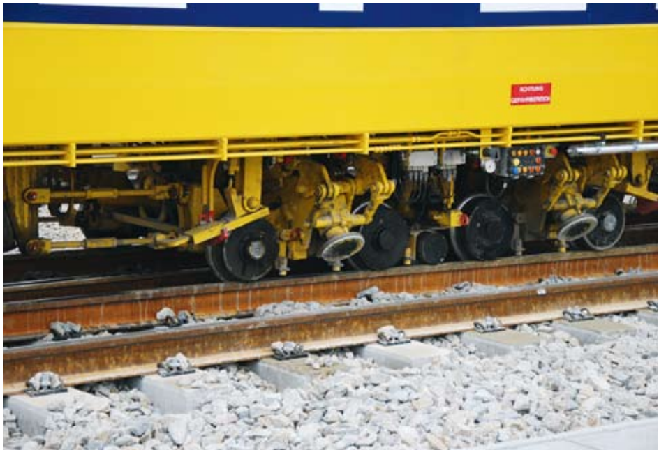
Abb. 12: Stabilisieren in Weichen
