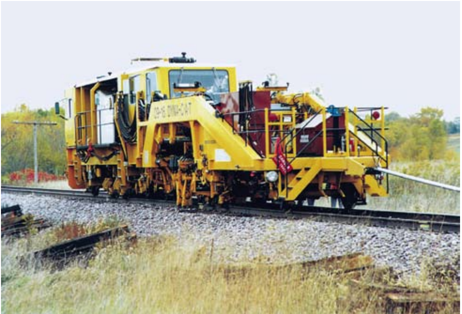
Abb. 11: Gleisstabilisator mit angebaute Stopftefl in Nordamerika
