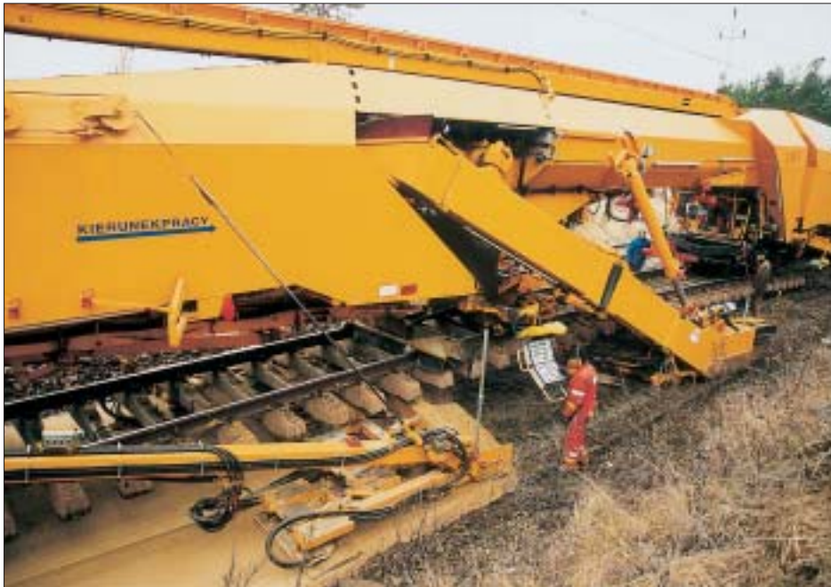
Bild 5: Materialaushub und Einbau einer verdichteten PSS
