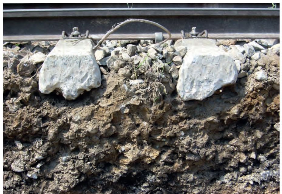
Abb. 1: Typischer Längsschnitt eines Streckenabschnitts mit fortgeschrittenen Untergrundproblemen
