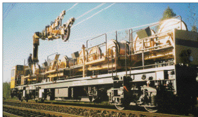
Bild 3: Fahrdrabverlegemaschine für gleichzeitig 3 Fahrdrähte
