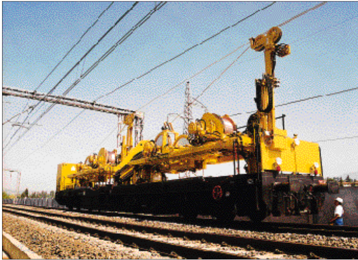
Bild 4: Fahrleitungs- umbaumaschine mit teleskopischem Richtturm
