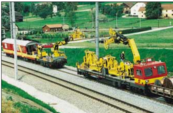
Abb. 19: Aufbau der neuen Oberleitungskette mit der Oberlei- tungsumbau- maschine FUM 100.046 und dem Montagewagen A 10
