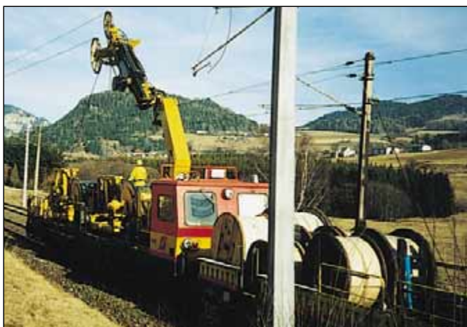
Abb. 15: Prinzipdarstellung der Arbeitsabläufe beim Aufbau der Verstärkungsleitung, des Rückleiters und der Montage der neuen Ausleger
