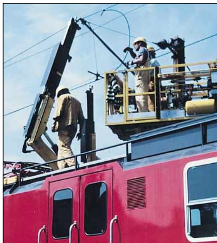
Abb. 10: Drückereinheiten im Einsatz bei Auslegerarbeiten
