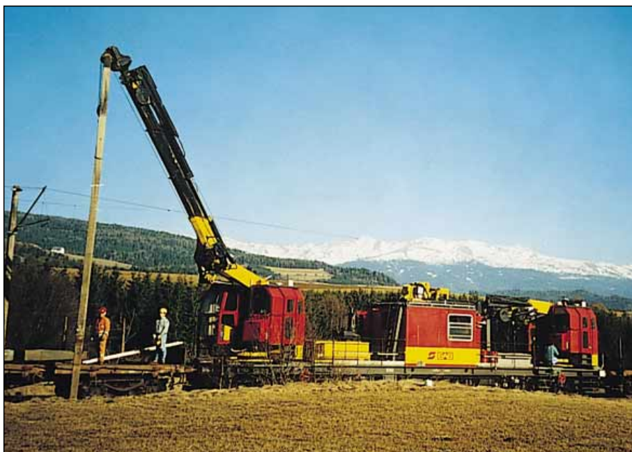
Abb. 2: Maststellgerät MAGE 75; Versetzen eines Oberleitungsstützpunktes mit der Seilwinde
