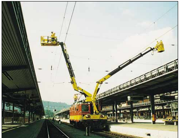
Abb. 6: Motorturmwagen für Oberleitungsba- und -instandhaltung MTW 100.013-2; Arbeiten mit der freierschwenkbaren Arbeitsbühne und dem Montagekorb
