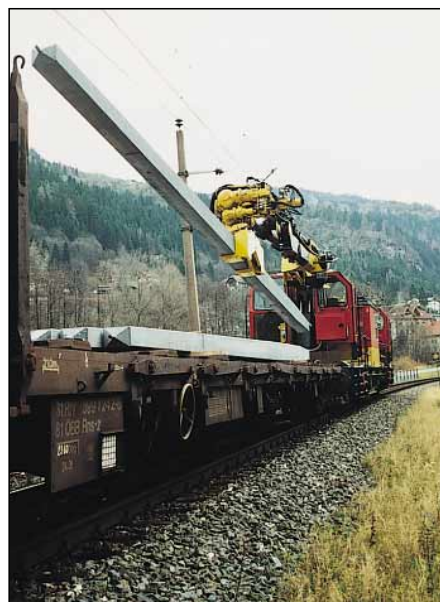
Abb. 3: Maststellgerät MAGE 75; Versetzen eines Oberleitungsstützpunktes mit dem Mastmanipulator
