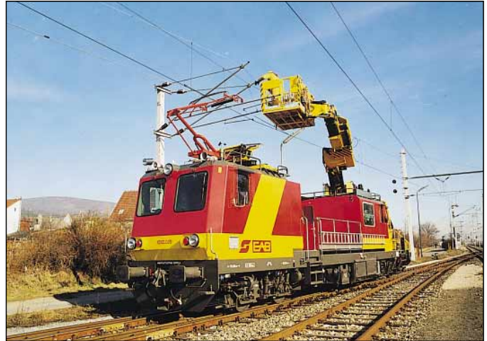
Abb. 4: Motorturmwagen für Oberleitungsbau MTW 100.083/1; Arbeiten mit der freischwenkbaren Arbeitsbühne
