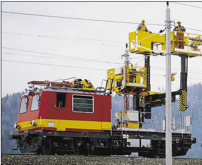
Abb. 5: Montageturmwagen für Oberleitungsbau MGW 10.003/3; Arbeiten auf den vollhydraulischen Hubarbeitsbühnen
