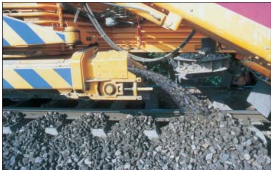
Bild 8: Verteilförderband zum Wiedereinbringen des gereinigten Schotters
